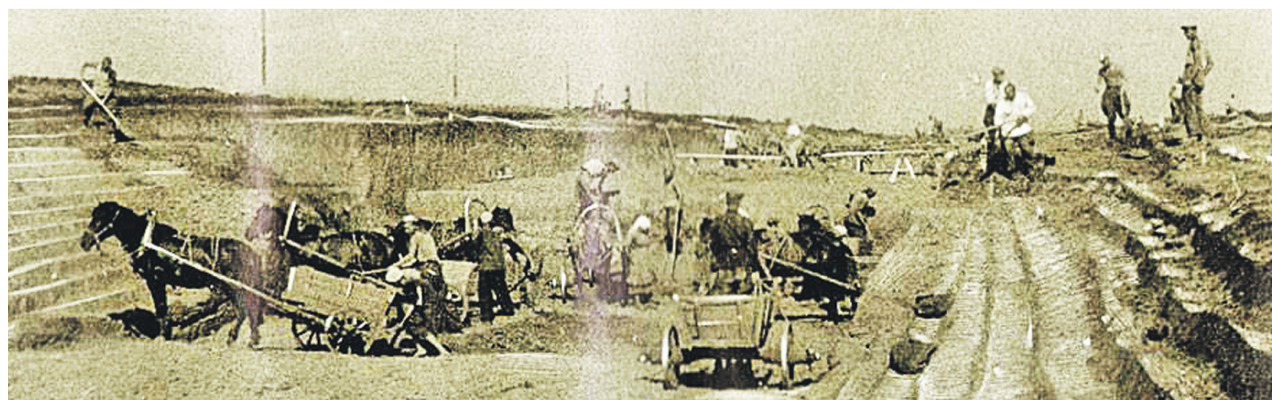
■ Разработка выемки грабарками на строительстве Волжской рокады.
