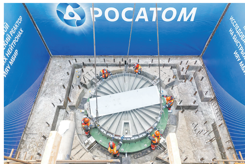
■ 18 января 2023 года корпус реактора установили в проектное положение.
