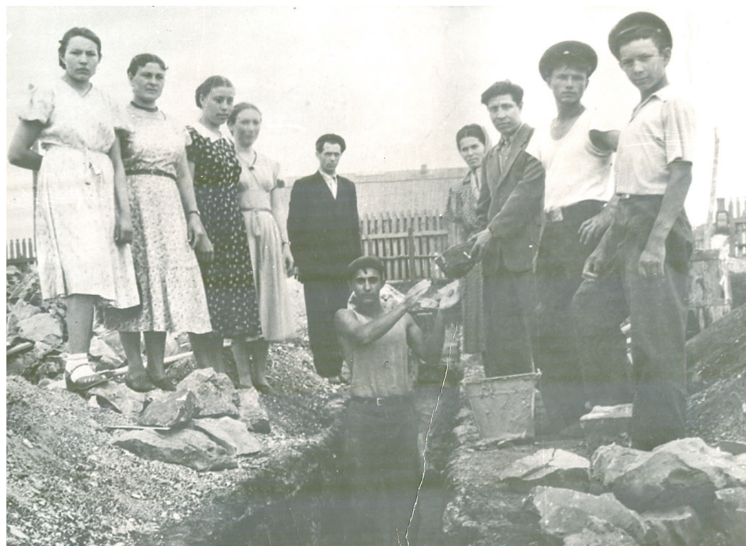
Хамзя Аблязов (третий справа) со старшеклассниками выкапывают котлован для здания интерната.
