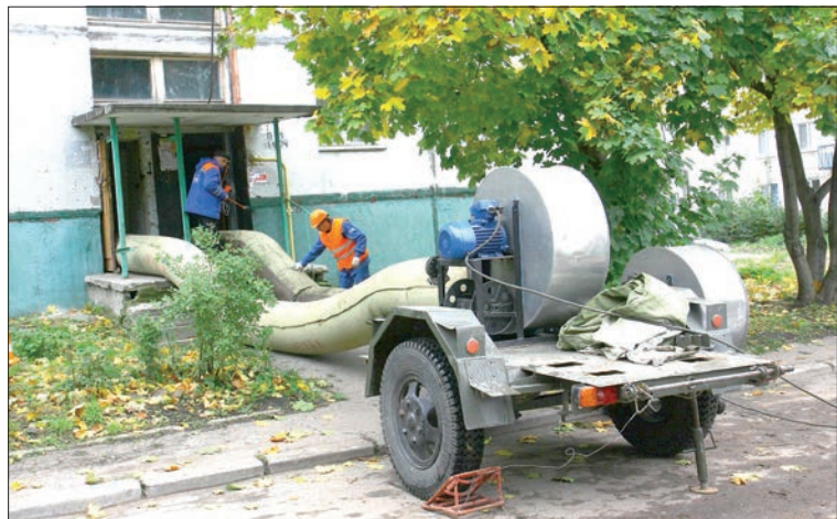
С помощью портативных установок идет вентиляция подвала.
