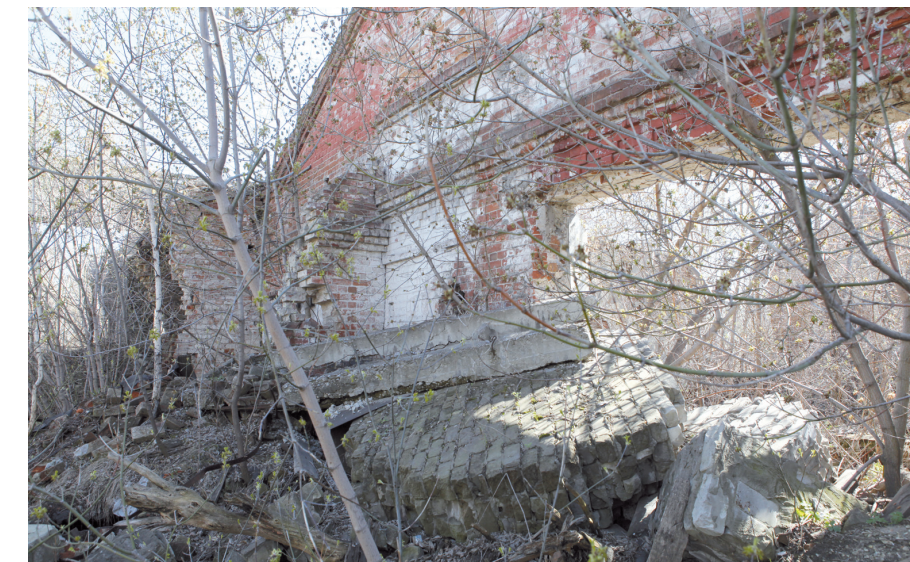
■ «Останки» чугунолитейного завода.
