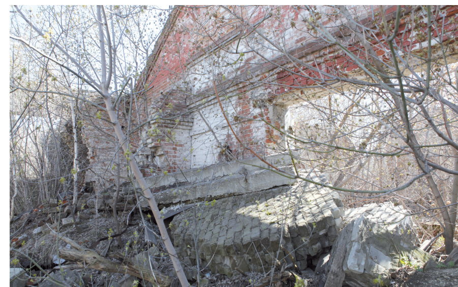
■ «Останки» чугунолитейного завода.
