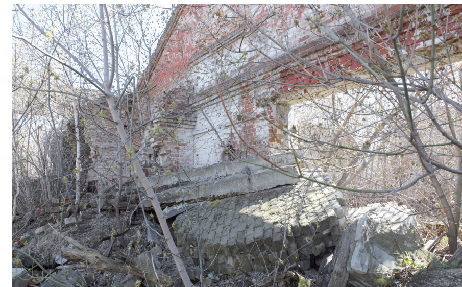
■ «Останки» чугунолитейного завода.
