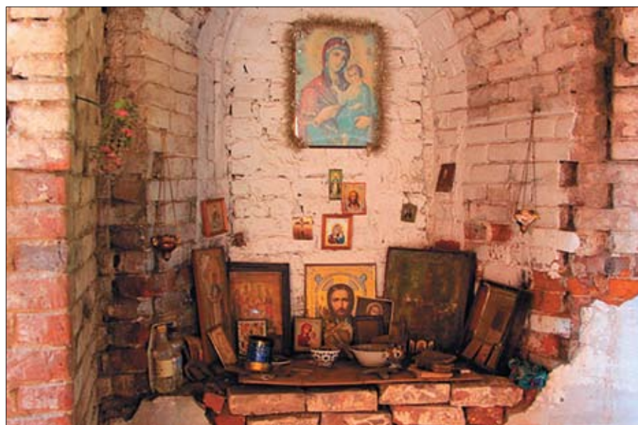
В руинированной Покровской церкви села Новиковка и сейчас проходят богослужения
