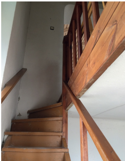
Лестница, ведущая на хоры
