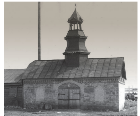
♣ Здание пожарного депо
