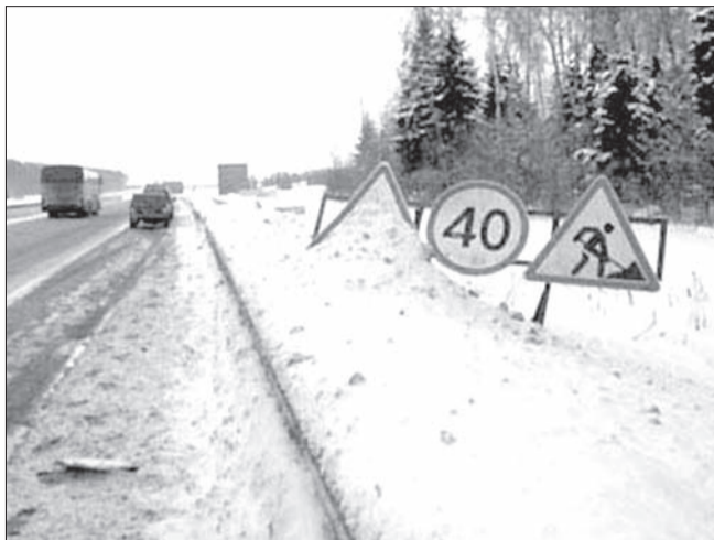
До 31 марта в Ульяновске отремонтируют 900 кв. м дорожного полотна. Работы будут вестись с применением литого асфальтобетона при температуре наружного воздуха до -10 градусов. В Ульяновске подобная технология применяется впервые.
