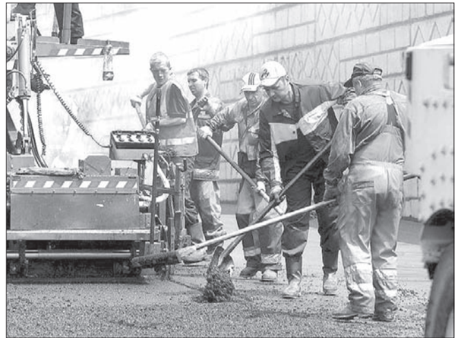
В Ульяновске карточный ремонт дорог идет с опережением графика. По данным на 27 мая, ремонт первого участка Московского шоссе от Пушкинского кольца до проспекта 50-летия ВЛКСМ, производимый ООО «Ремстроймост», выполнен на 99%. Здесь было уложено порядка 17 тыс. кв. м нового асфальта.
