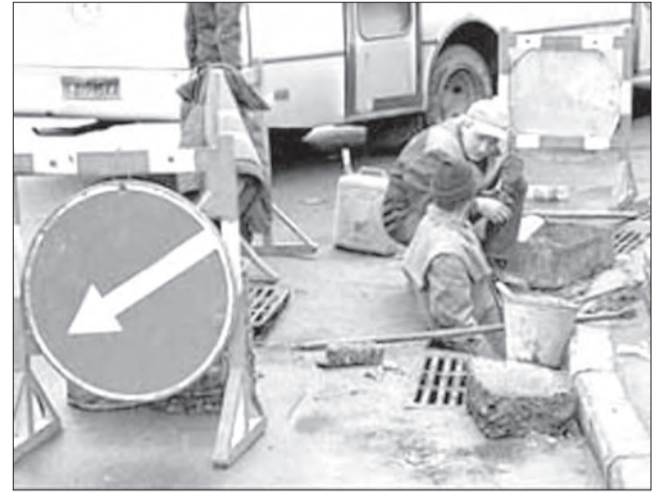
С начала весеннего строительного сезона в Ульяновске посредством ямочного ремонта приведено в порядок порядка 76 тысяч кв. м. струйно-инъекционным методом - 108 тысяч пог. м дорог.
