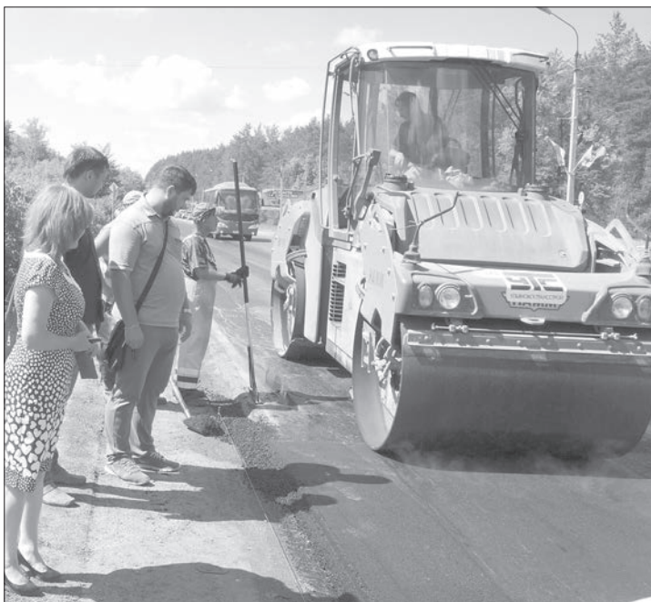
Участникам мероприятия был продемонстрирован процесс укладки и укатки асфальта специальной техникой
