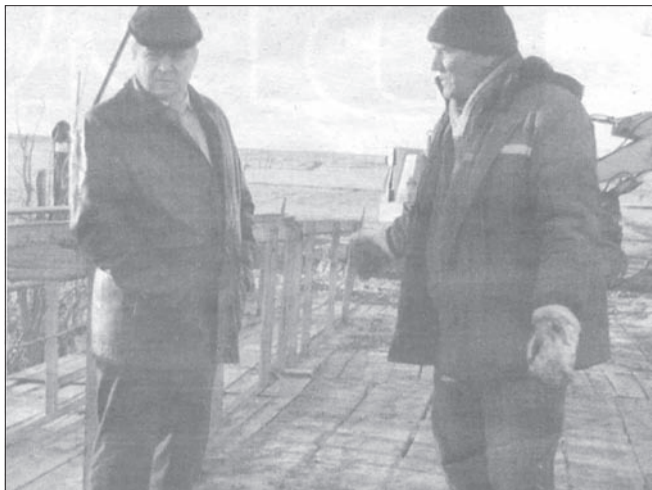
По просьбам жителей и ходатайству администрации Кузватовского района губернатор Сергей Морозов принял решение произвести внеплановый ремонт мостового перехода через реку Свягу на автомобильной дороге Стоговка - Екатериновка. 28 декабря строители планируют сдать мостовой переход.
