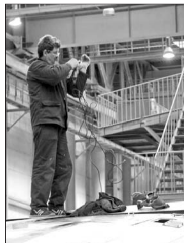
Бортовой номер 0104: монтаж систем
