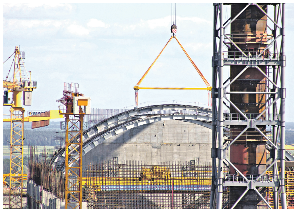
■ Длина пролета арки составляет 38 метров.
