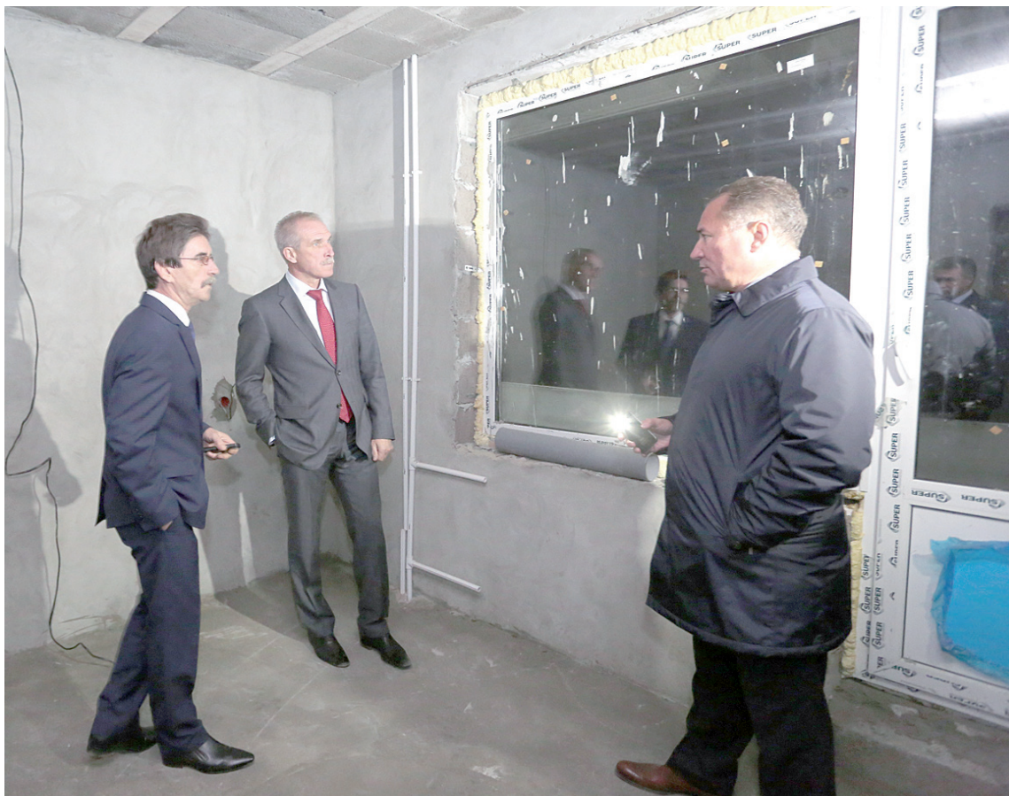
Многквартирный дом будет готов до 1 ноября.
