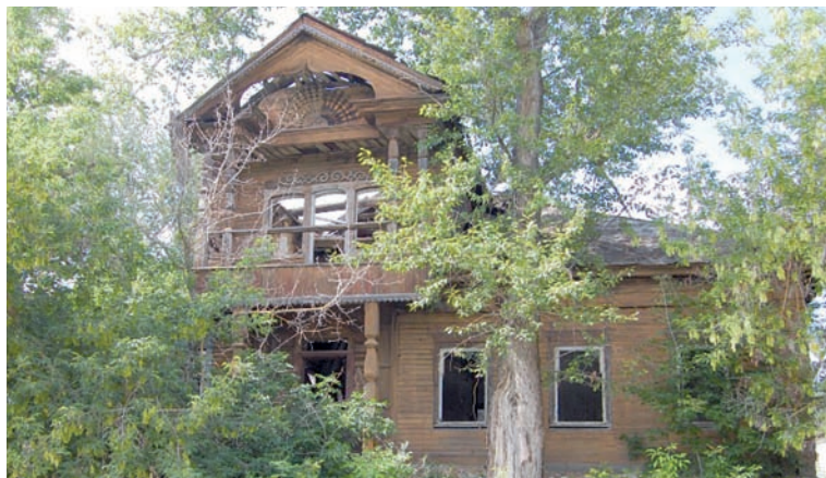
Здание суконной фабрики в селе Лесное Матюнино находится в аварийном состоянии.
