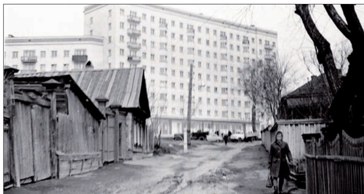
По обе стороны спуска стояли одноэтажные деревянные дома.
