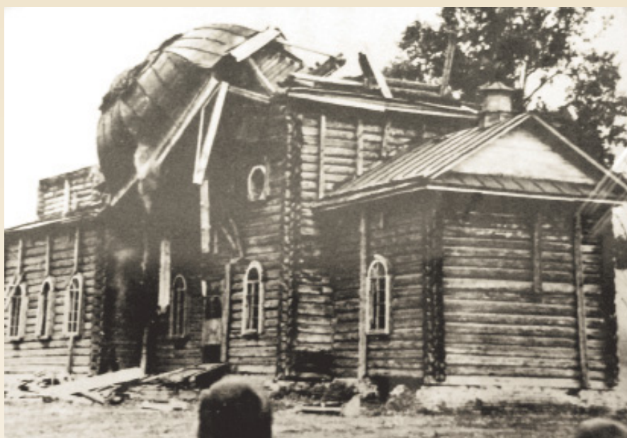
Разрушение церкви в селе Прислониха. 1937
