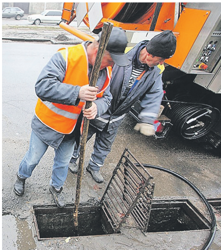
■ Наиболее масштабные работы в муниципалитете в этом году начнутся по строительству очистных сооружений.
