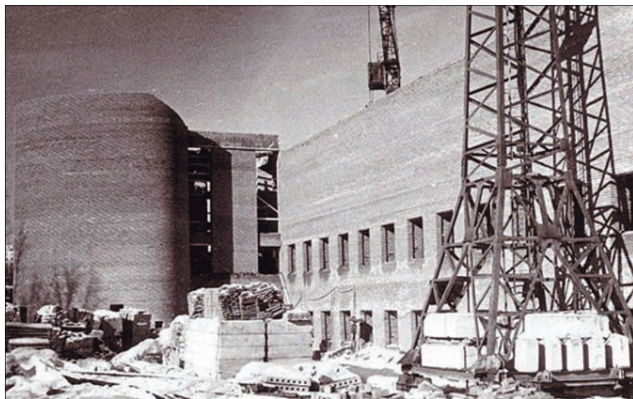
Строительство Палеонтологического музея АН СССР
